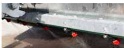
Dispositif d'arrosage – les buses de protection anti-éclaboussures protégées sur le carter pulvérisent l'eau près de la brosse et empêchent la production de poussière
